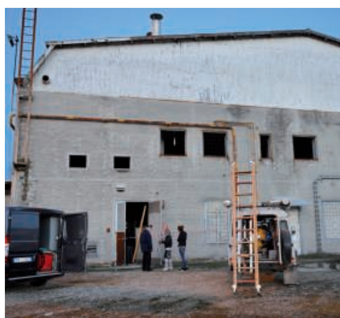
Dentro una cabina elettrica. Un nomade ha scoperto il corpo mummificato
