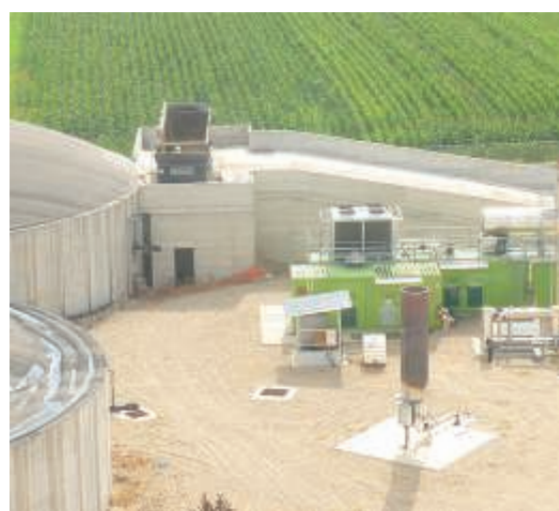
La centrale a biogas di Piobesi in costruzione (agosto 2013).
